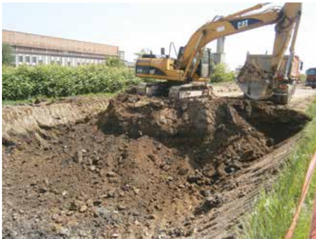
Početak radova na drugoj etapi Radničke ceste (svibanj 2013.)
