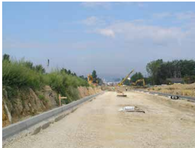
U buduću se prometnicu već ugrađuju i betonski rubnjaci
