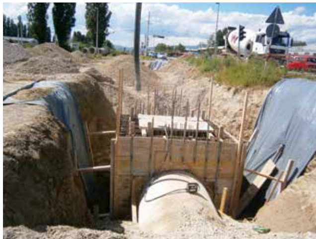
Betoniranje jednog revizijskoga kanalizacijskog okna
