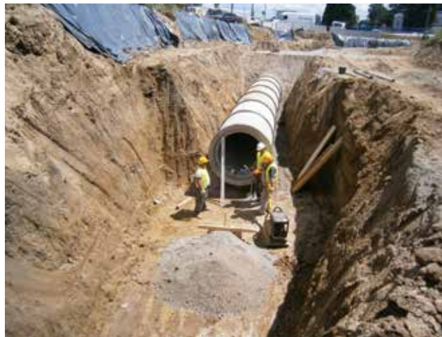
Polaganje kanalizacijskih cijevi (srpanj 2013.)
