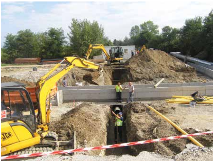
Gradnja kanala i ugradnja kanalizacije uz rub prometnice
