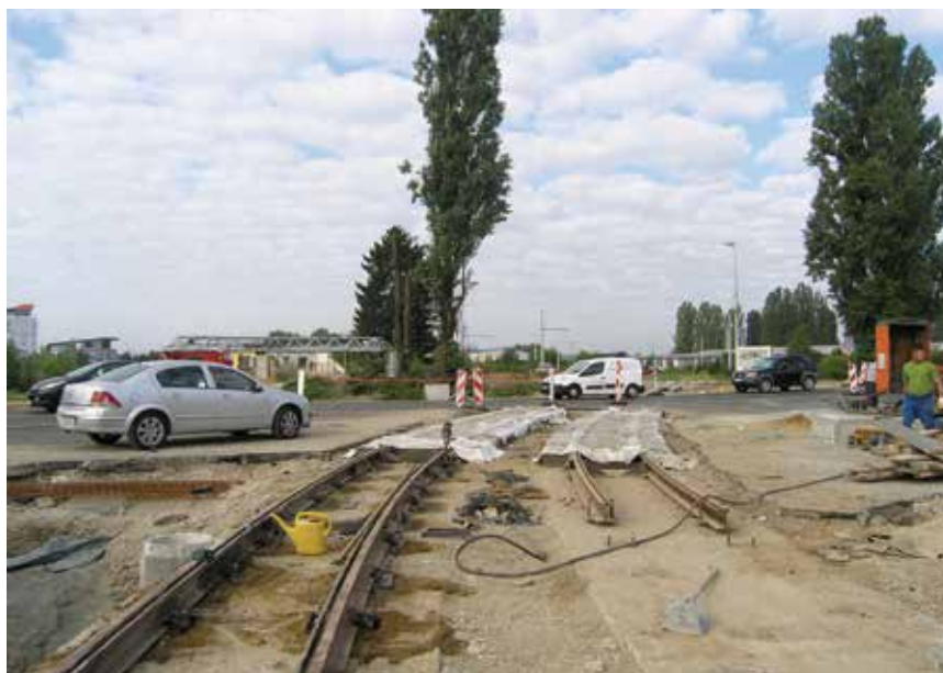
Radovi na premještanju tramvajske pruge na križanju s Ulicom Koledovčina
