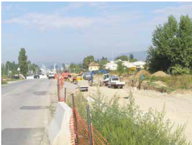
Pogled na gradilište na križanju Radničke i Koledovčine
