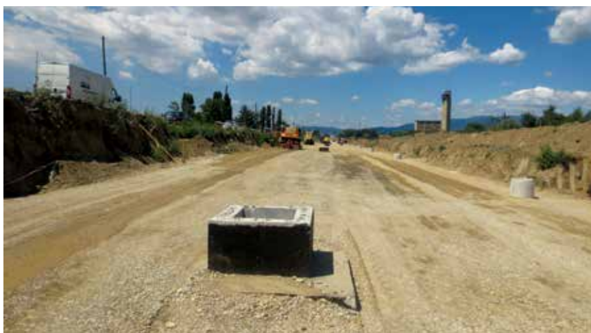
Revizijsko okno u trupu buduće prometnice
