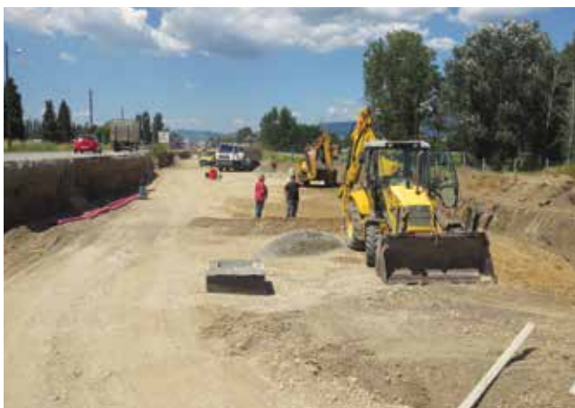
Početak radova na novom kolniku (srpanj 2013.)
